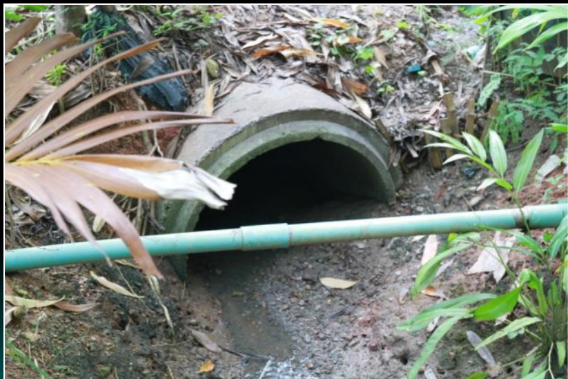
ตะกอนทับถมในท่อลอด
